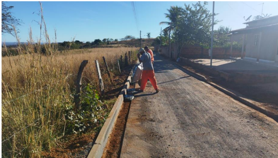
Figura 3: Lançamento do concreto
