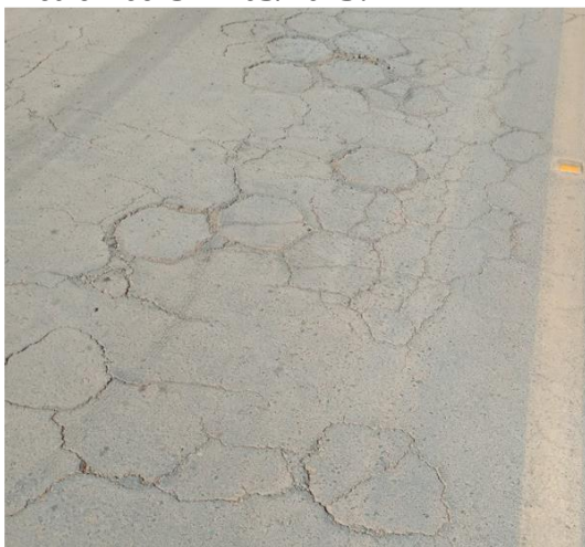
Figura 1: Trincas no pavimento executado em Cotegipe-BA
