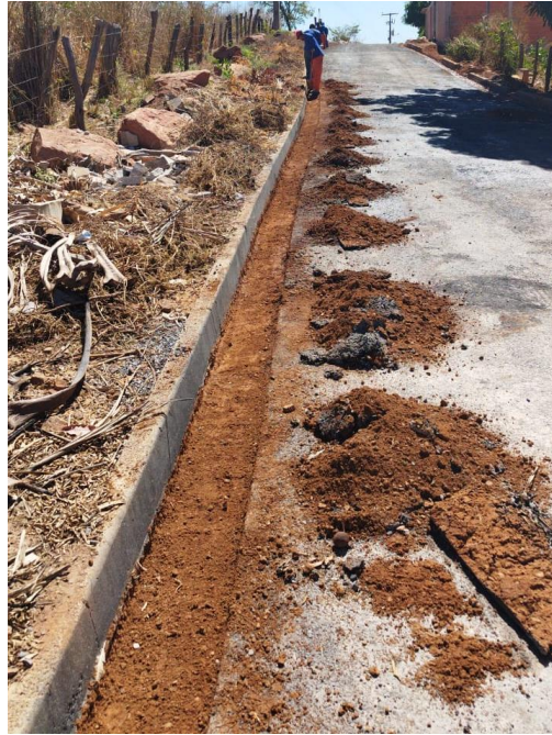
Figura 2: Retirada do material e limpeza para concretagem
