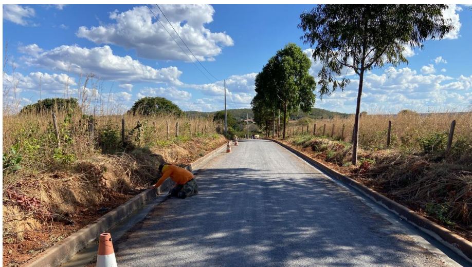
Figura 4: Acabamento e finalização da sarjeta
