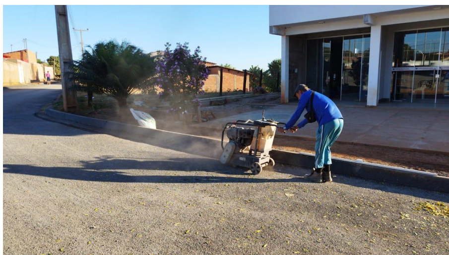
Figura 1: Corte para execução de sarjeta
