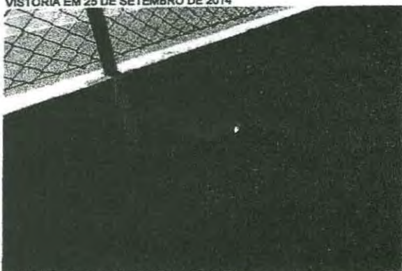
25-QUADRAS DE TENIS. POSTES DE ILUMINAÇÃO RETIRADOS.
