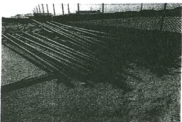
35-POSTES DE ILUMINAÇÃO RETIRADOS DAS DIVERSAS QUADRAS
