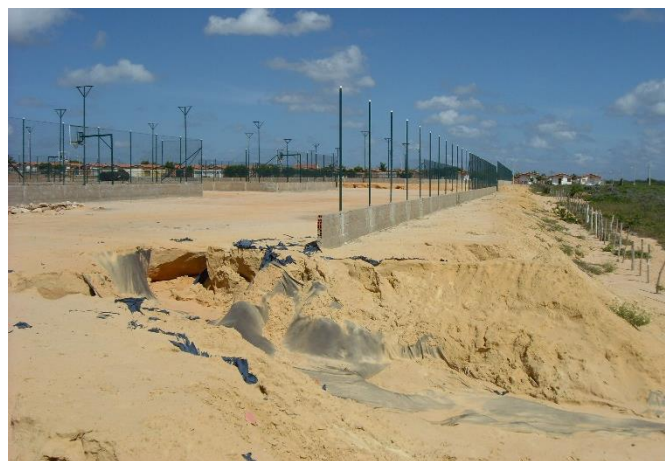
Erosões dos Terraplenos. Fonte: Relatório de Auditoria – jun/2013
