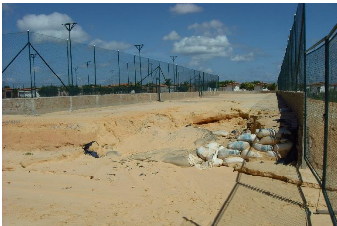
Erosões dos Terraplenos. Fonte: Relatório de Auditoria – jun/2013
