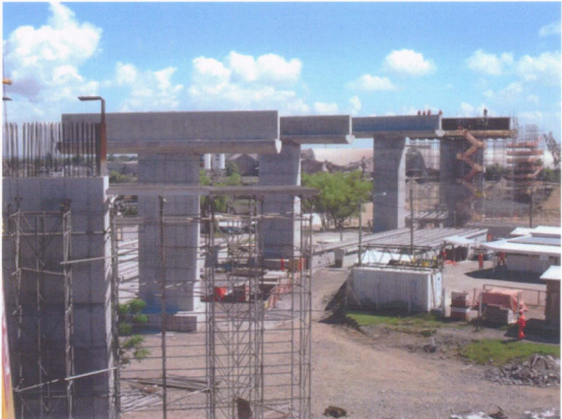
Figura 04 – Estruturas em concreto pré-moldado.
