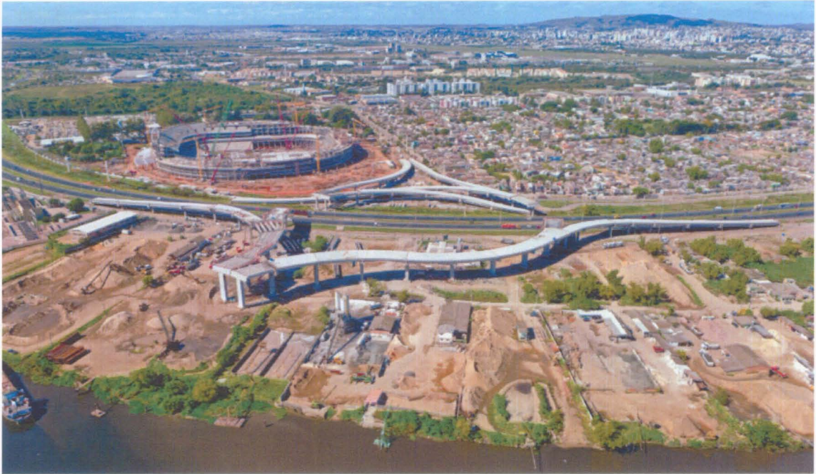
Figura 03 – Viaduto de acesso a BR-290/RS.
